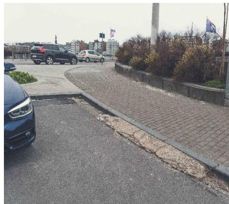
26. Sur le trottoir du pont Albert, côté amont, enlever le piquet au milieu du trottoir et rénover le revêtement en très mauvais état du pont et y placer un marquage délimitant la séparation des zones piétonnes et cyclables.
