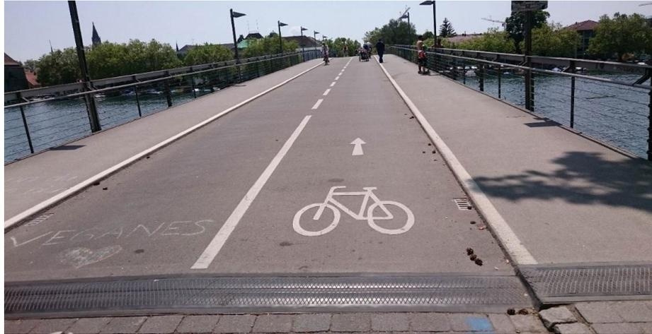
*Figure 3 : Passerelle cyclo-pédestre à Konstanz (Allemagne). L'espace central est réservé aux cyclistes en double sens et les espaces sur les côtés (trottoirs) aux piétons.*
